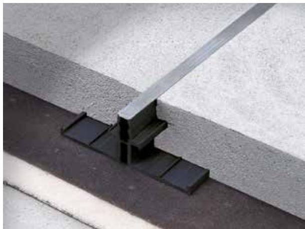
Giunto indicato per posa a malta realizzato in materiale sintetico a doppia densità. E' costituito da due parti strutturali rigide unite da inserti in materiale plastificato morbido disponibili in più colori. Il giunto CMB viene utilizzato per frazionare il sottofondo o il massetto secondo quanto previsto dal progetto.
